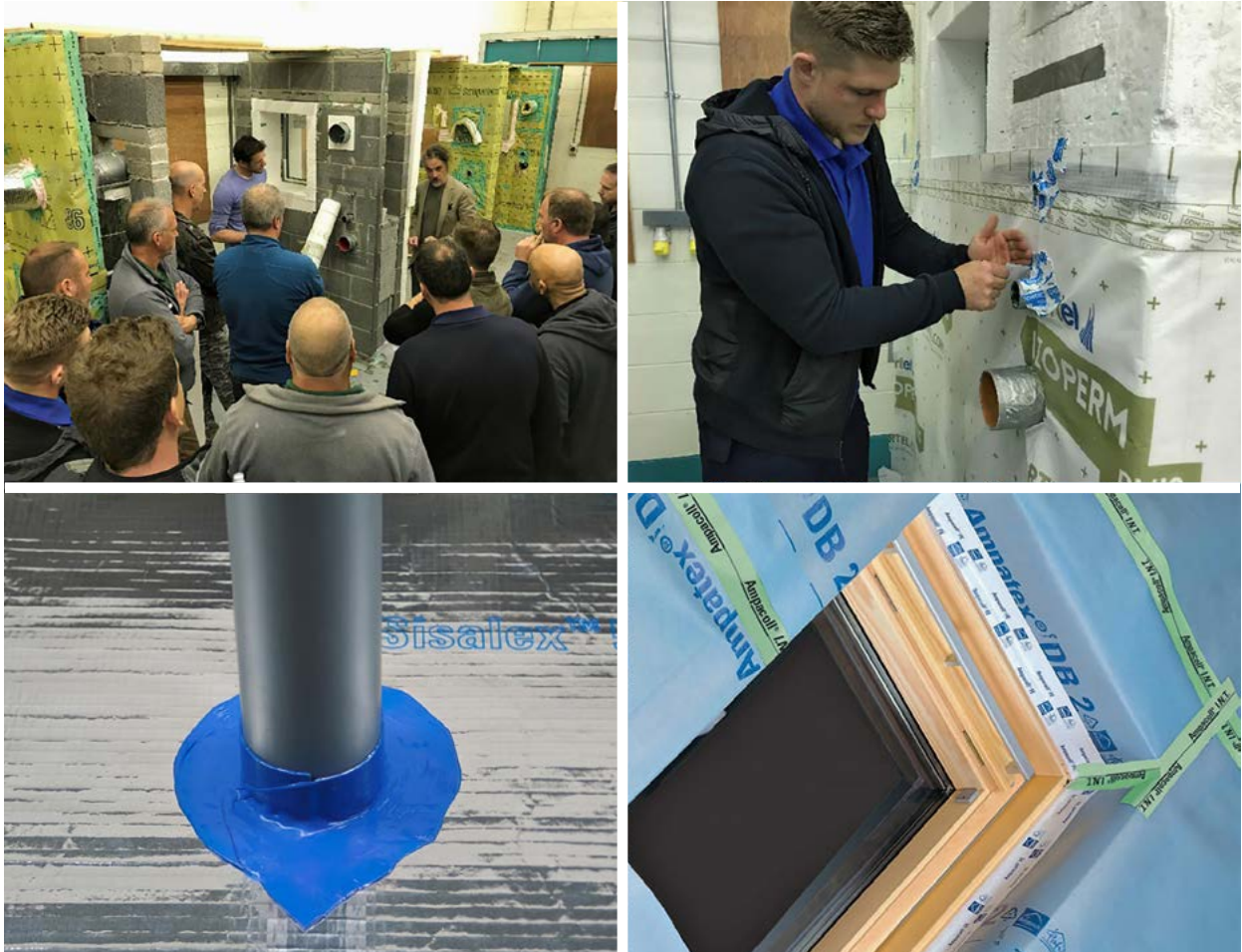
Figura 1 | Hands-on: artigiani e professionisti al corso per operatori di cantiere Passivhaus, sigillature a tenuta all'aria con membrane liquide, nastri e teli.
