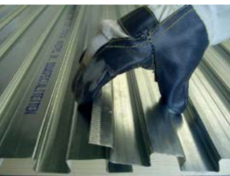
Sovrapposizione longitudinale dei pannelli
