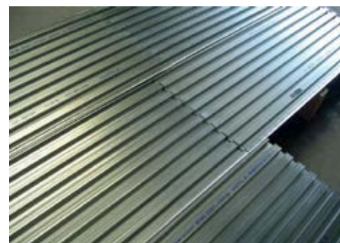
Sovrapposizione trasversale e longitudinale dei pannelli
