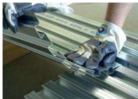
Sovrapposizione trasversale dei pannelli
