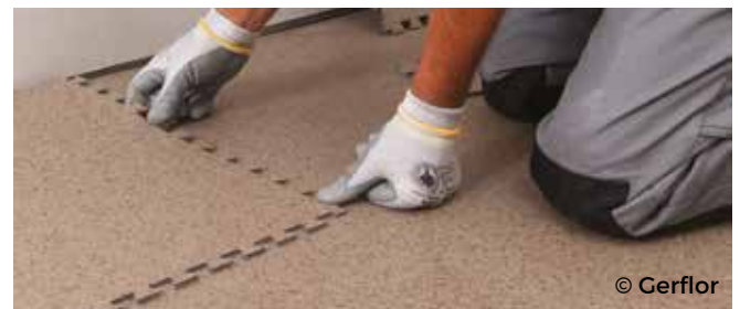
Figura 53 - Rivestimenti in piastre
