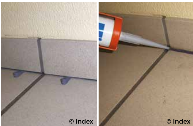
Figura 46 - Particolare del distacco del battiscopa dal pavimento attraverso cunei distanziatori e successiva sigillatura elastica con silicone.
