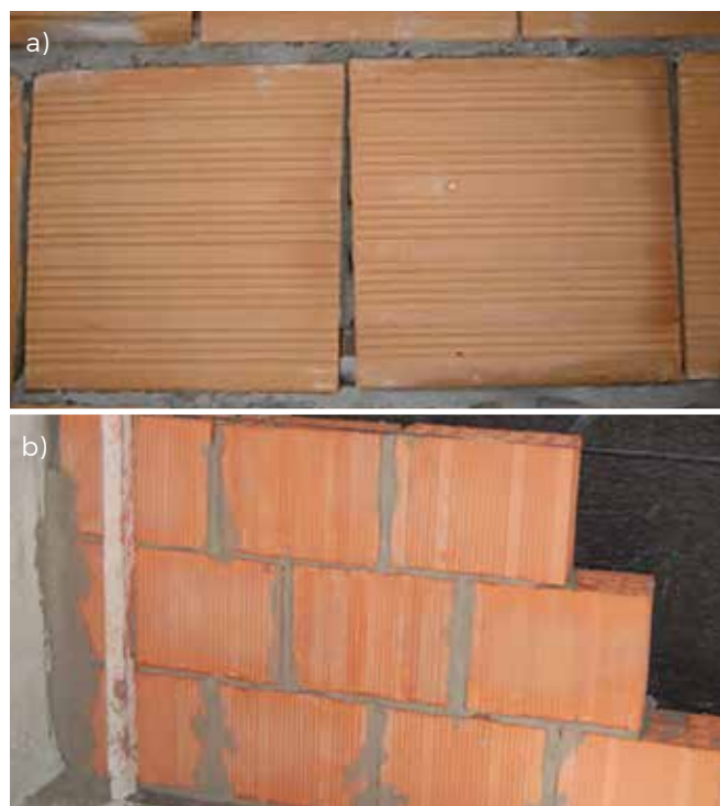
Figura 5 - a) Esempio di errata posa in opera per la mancanza del giunto di malta in verticale. b) I giunti di malta in verticale aumentano la massa della parete.
