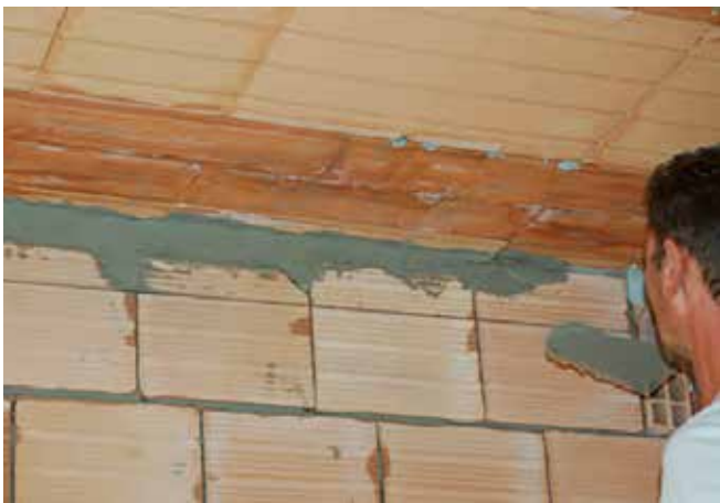
Figura 7 - Riempimento con abbondante malta tra ultimo corso di mattoni e soffitto
