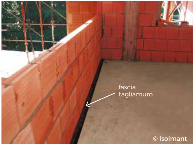
Figura 6 - Posa in opera della fascia tagliamuro
