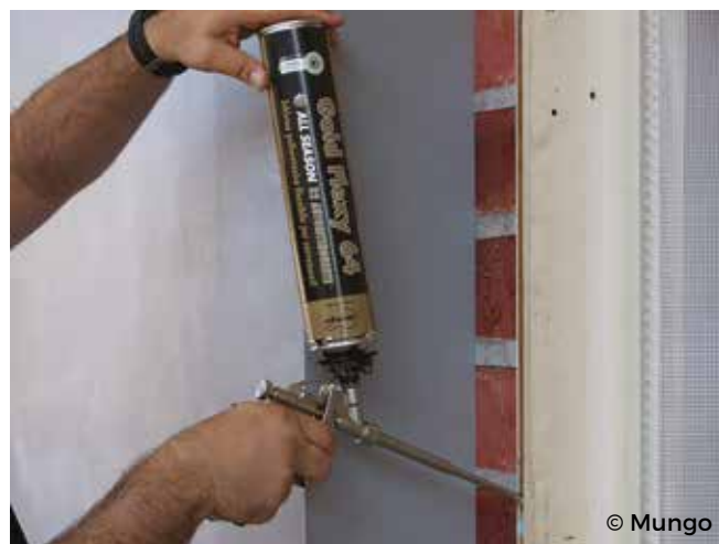
Figura 24 - Esempio di riempimento con schiuma flessibile
