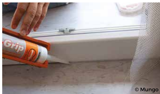
Figura 25 - Esempio di sigillatura con silicone
