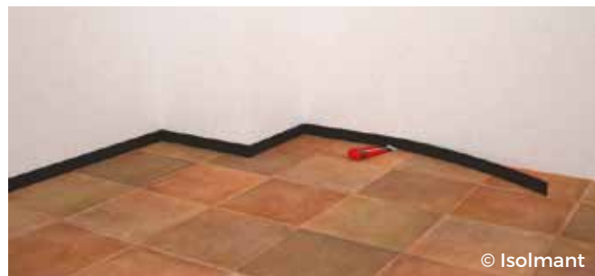
Figura 44 - Rifilatura della eccedenza della fascia perimetrale al termine della posa e stuccatura della pavimentazione
