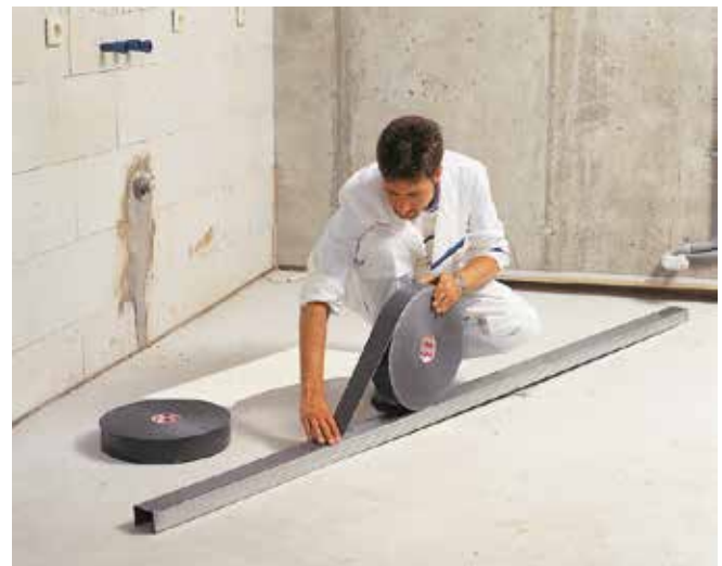
Figura 9 - Posa della striscia desolidarizzante
