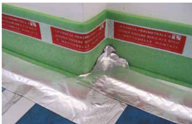
Figura 43 - Particolare del corretto collegamento fascia perimetrale-materassino anticalpestio; la nastratura deve essere sempre continua.
