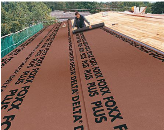
• Fissaggio con doppia banda adesiva integrata.
