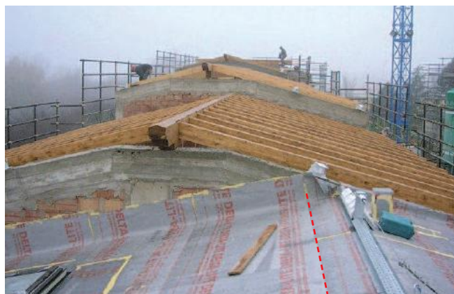
• Posa della membrana traspirante a cavallo del colmo: sovrapposizione lungo la linea tratteggiata.
