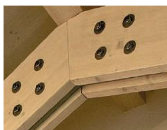
• Unione mediante bulloni.
