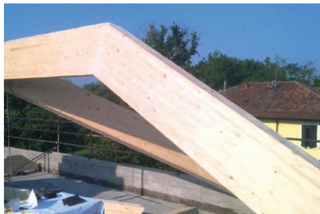
• Esempio di unione con piastra incollata (trave ginocchio).
