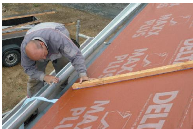
• Posa della guarnizione punto chiodo (foto sopra e sotto).
