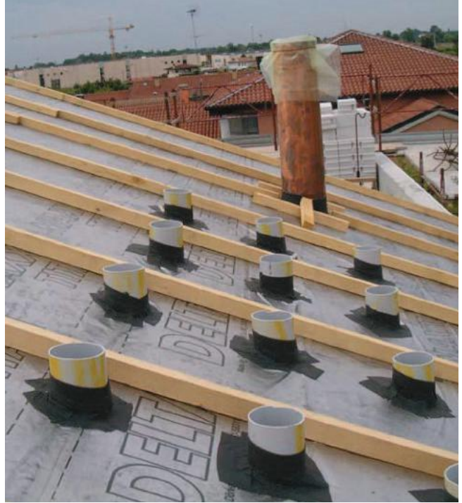
• Sigillatura di elementi curvilinei (areatori) mediante banda adesiva elastica.
